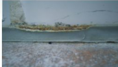
Verschimmelte Silikonfugen müssen zuerst
