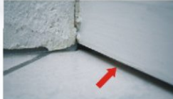
Vor dem Einfüllen der neuen Silikonmasse zuerst den Lärgerand der Fuge mit Jati-Schimmelpilz-Entferner® behandeln.
